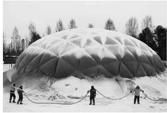
het spuiten van water met houtvezels
